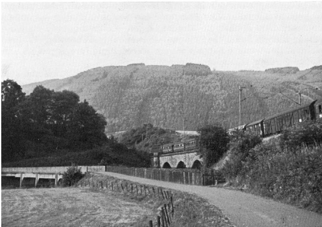
Die im Jahre 1861 erbaute Lennebrücke der Lennetalbahn.
