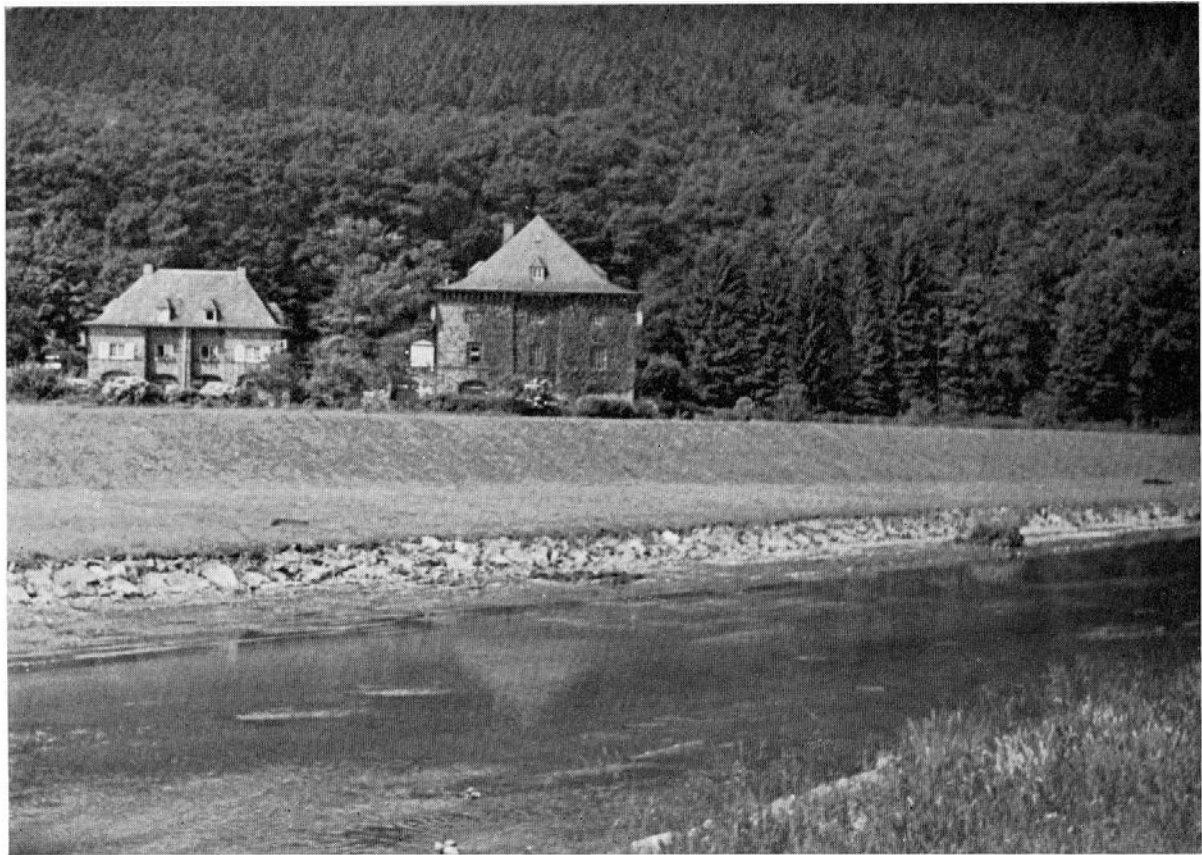
Das Kraftwerk der Lister-Lenne-Werke am Lenneknie im Ohl
