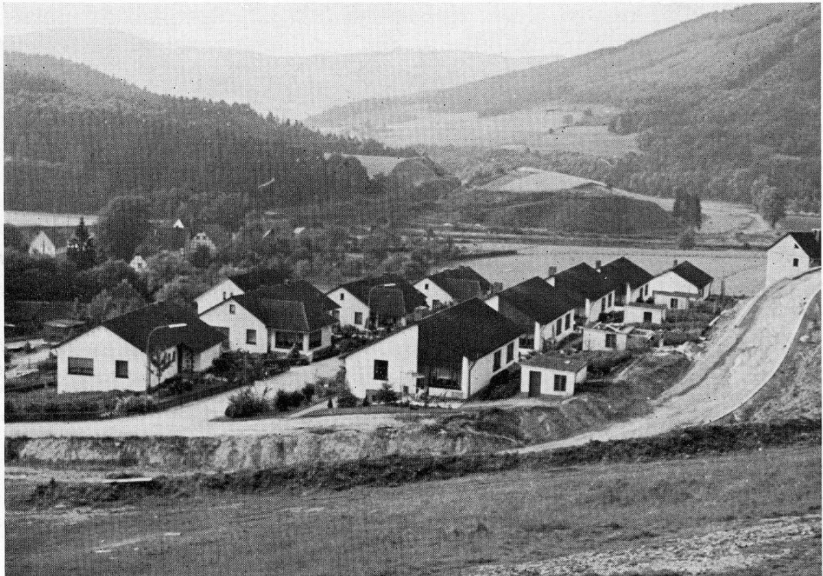
Neue Siedlung am Mühlenberg
