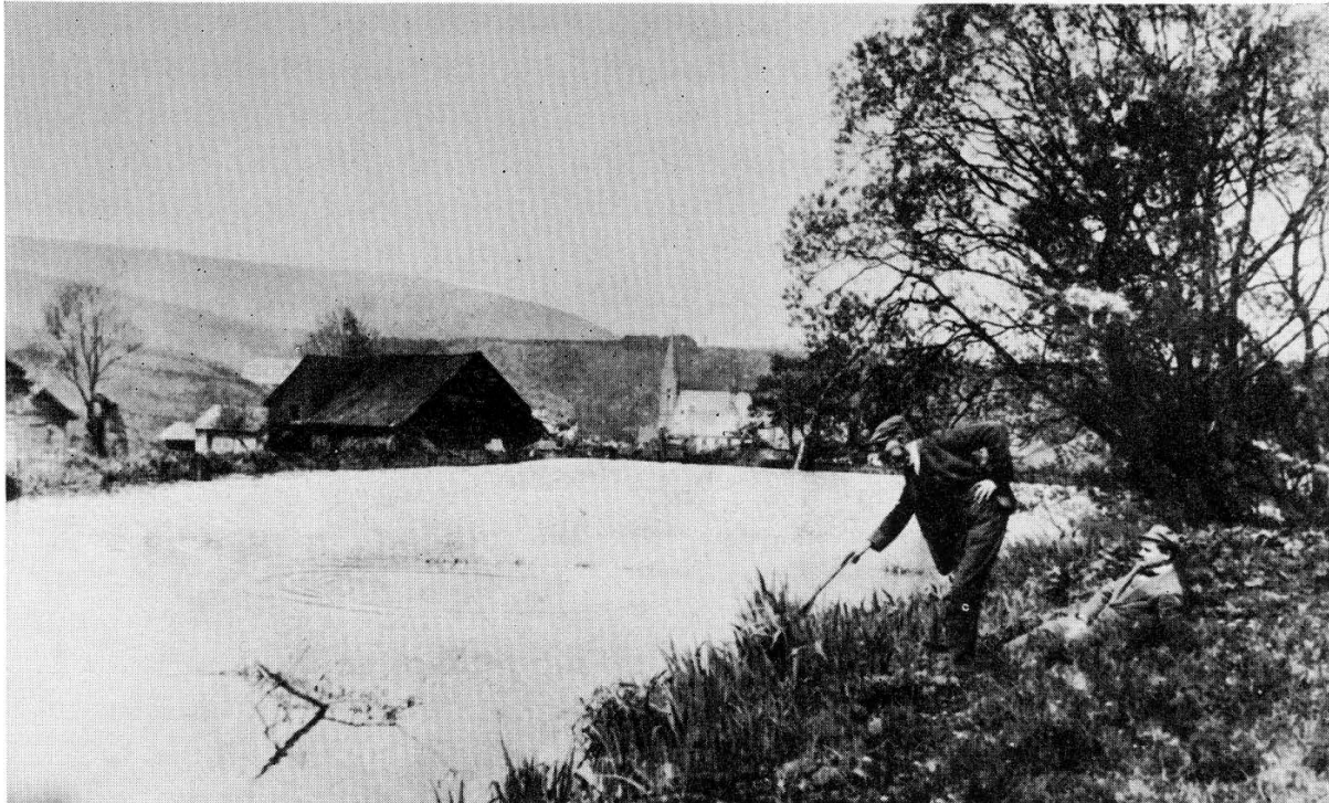
Der „Untere“ Hammer mußte nach dem 1. Weltkrieg stillgelegt und abgetragen werden. Er hat über 300 Jahre bestanden.
