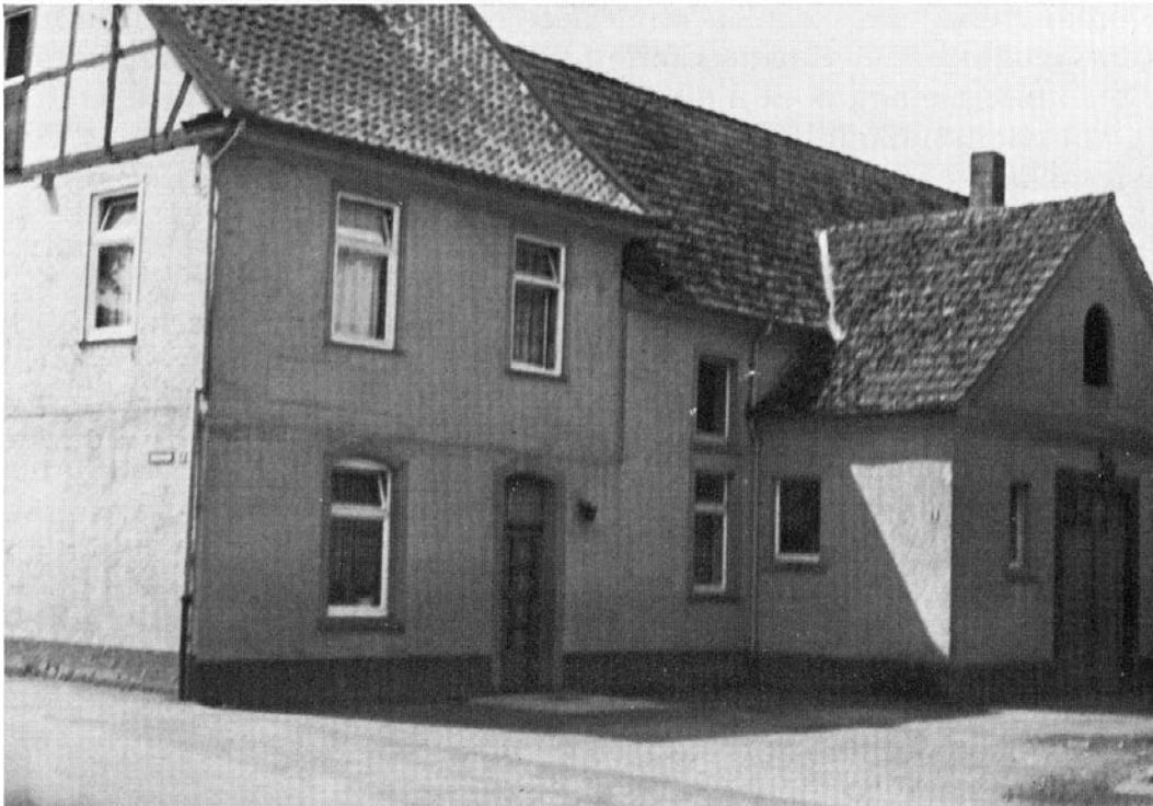
Das erste Schulgebäude im Dorf
