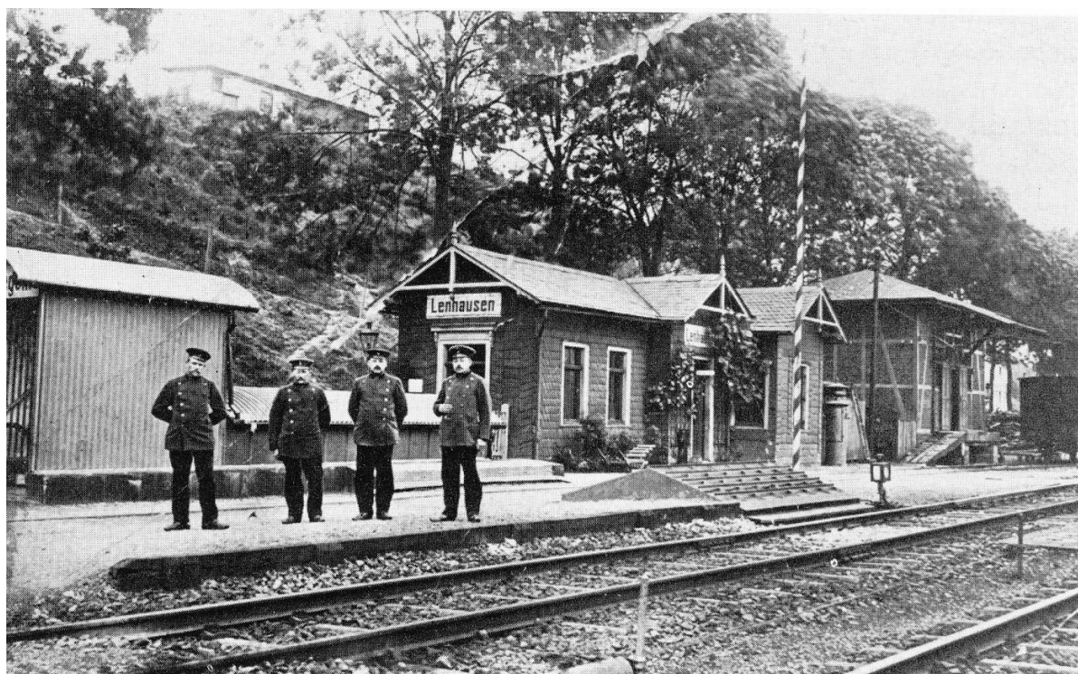
Das alte Bahnhofsgebäude mit Unterführung
